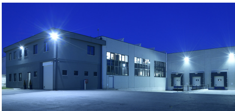
Il nuovo edificio produttivo, che ha esteso la sede italiana di UNIVET S.r.l. a Rezzato (BS).
